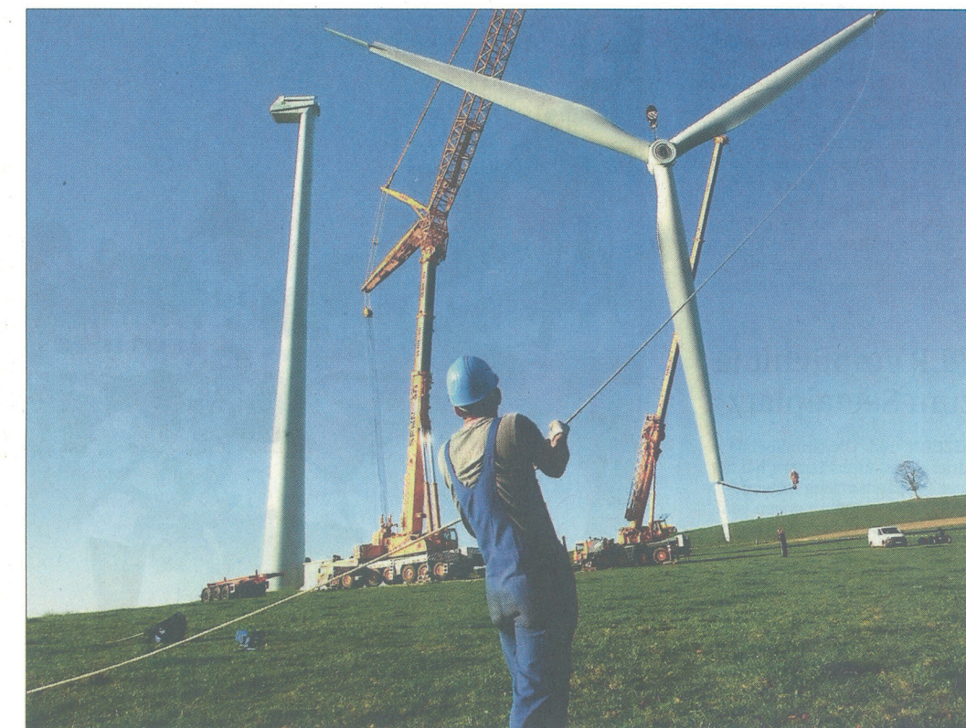
Im Entlebuch stehen bereits Windräder: Im Bild die Montage einer 60 Meter hohen Anlage in Rengg, im Oktober 2005.
