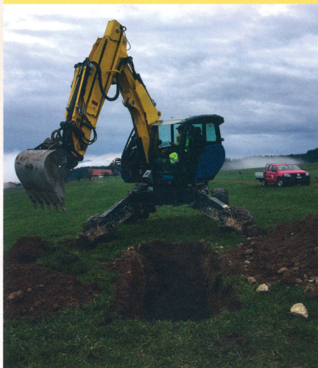
Abb. 2: Baggerarbeiten an einem Sondierschacht im Gebiet Grod / Nord.
